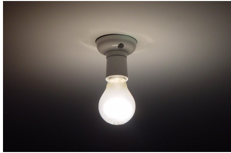
Abbildung 23: Eine Glühlampe erzeugt viel mehr Wärmestrahlung als sichtbares Licht. Trotzdem ist die Lichterzeugung ihre Hauptfunktion.
